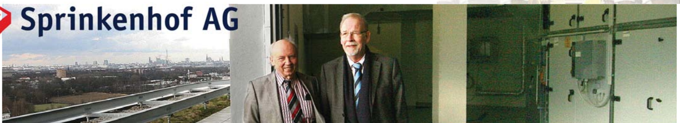
Ernst Rosendahl und Henning Tants in der Lüftungszentrale auf dem Dach der BSU in Hamburg.
